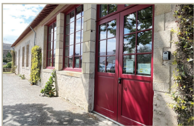
“ Entrée par la place Vignoboul ”
